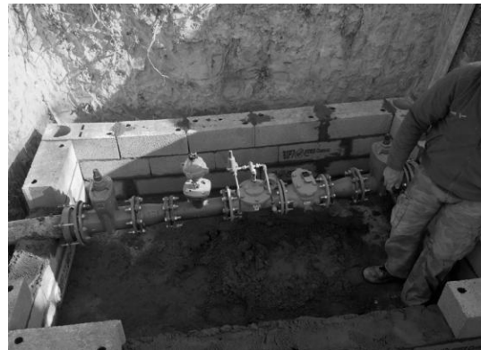
Renouvellement et protection du réseau d'eau potable secteur « Tuquet Blanc » à Pujols
