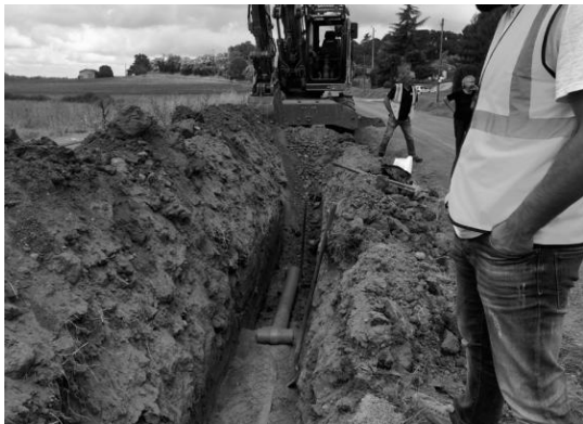
Renouvellement de canalisation lieu dit « La Priolette » à Mauvezin-sur-Gupie
