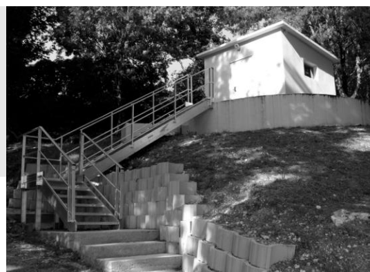
Station de reprise de Anthé
