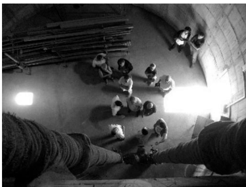
Château d'eau de Beaufuy
